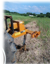
弾丸暗渠施工の様子
