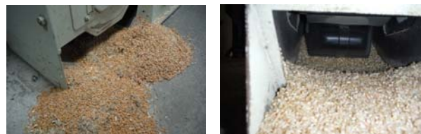
図2 前回使用後に設備内に放置されていた塵埃や米くず等の例 (右: 乾燥機、左: 粉すり機)
