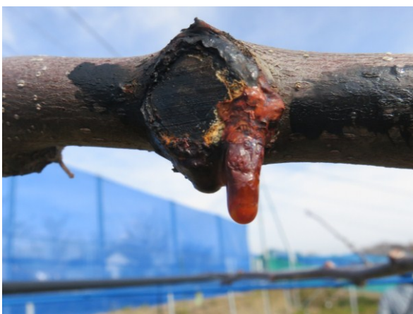
図 53 剪定痕からの樹液漏出 (表面が乾いて膜状となっているが、 内部には粘性のある液が含まれる) (平成 27 年2月)
