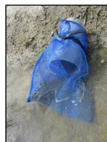
「あさり袋 4mm 目 39×55mm 株式会社イノベックス」 を使用。ゴムバンドで 取水口に設置
