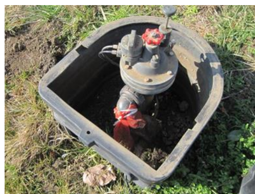
写真2 取水口ネット（伊勢原市）
