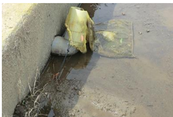
写真1 取水口ネット（平塚市）
