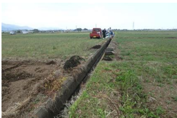
写真 5 用排水路泥上げ（平塚市）①
