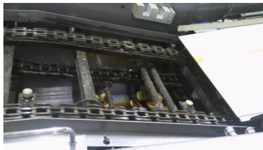
（写真5）トンネルオープン出口コンベアー
