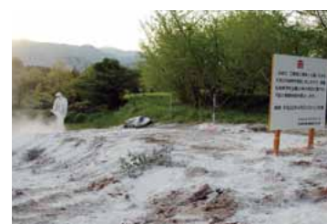
埋却場への消石灰の散布作業
