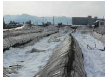
雪により倒壊したビニールハウス(ぶどう栽培)(山梨県)
