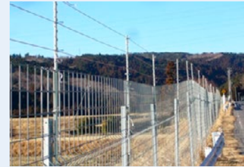
複数獣種に対応した防護柵 上段がサル用電気柵 下段がシカ・イノシシ用 ワイヤーメッシュ柵
