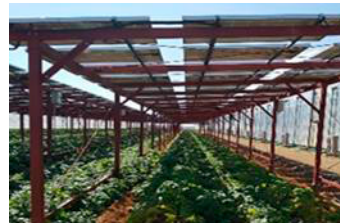
電気代の削減が可能な 営農型太陽光発電設備
