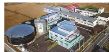
みやま市バイオマスセンター「ルフラン」
