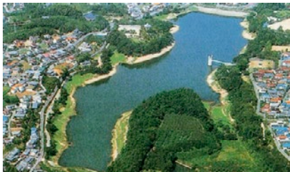
寺ヶ池・寺ヶ池水路(大阪府河内長野市)
