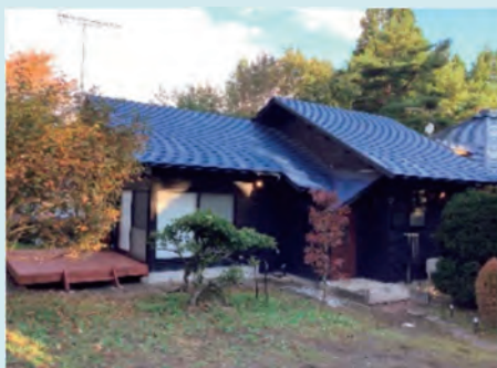
空き家となっていた別荘を整備して 農泊施設として活用
