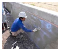
水路壁の補修
