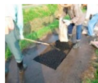
農道の部分補修
