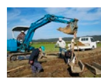
コンクリート 水路の更新
