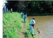
法面の草刈り
