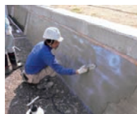
水路壁の補修
