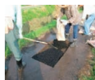
農道の部分補修
