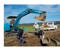
コンクリート 水路の更新
