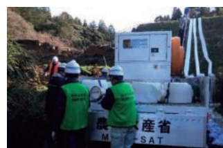
MAFF-SATによる災害応急対策の支援 (ため池における排水ポンプの設置)
