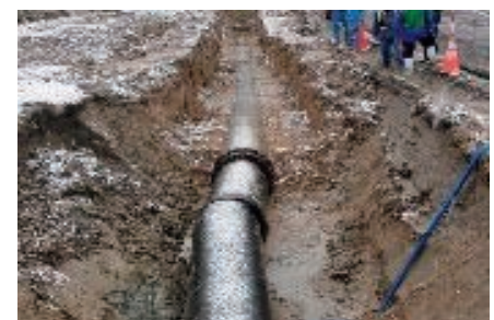
破損した農業用パイプライン
