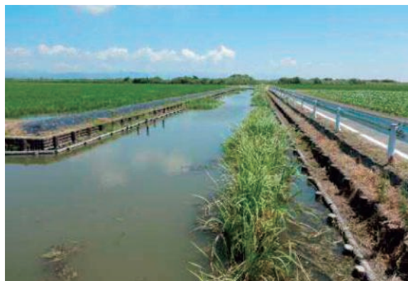
多様な水深を確保する多自然型護岸
