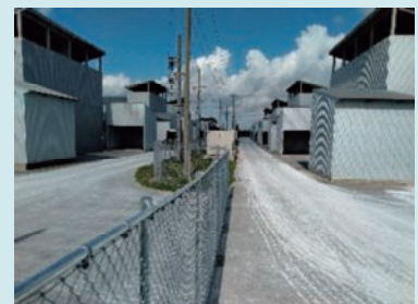
鶏舎群を区切る鉄製フェンス
