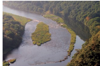
建部井堰(岡山県岡山市)
