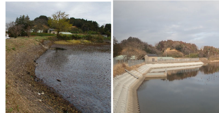
高上げ工事前後のため池堤体 資料：茨城県
