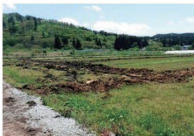
(作付け開始前に暗渠排水を施工)
