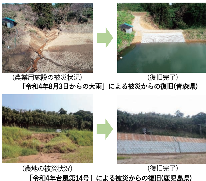
図表5-2-2 令和4(2022)年度の自然災害からの復旧状況
