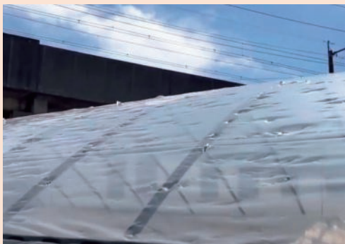
雹害により多数の穴の開いたビニールハウス
