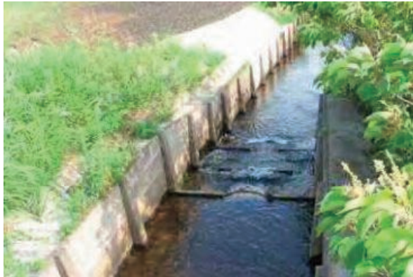
魚類の移動障害を解消する水路魚道
