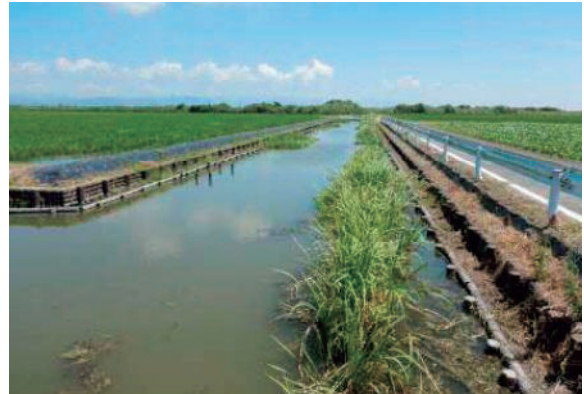
多様な水深を確保する多自然型護岸
