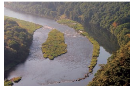
建部井堰(岡山県岡山市)
