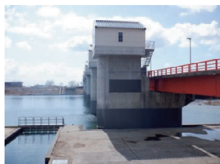
堰柱を拡張し耐震補強された頭首工
