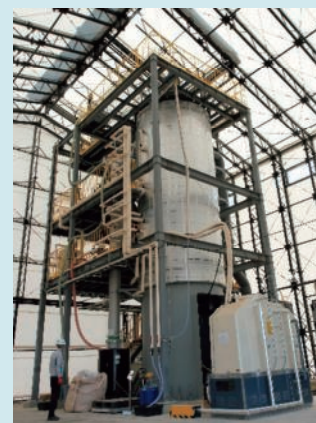
メタン発酵施設
