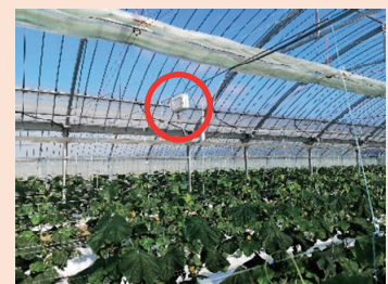
重点支援地方交付金を活用した事業で導入された環境制御装置(丸印)
