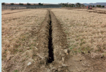
暗渠排水管を敷設した圃場
