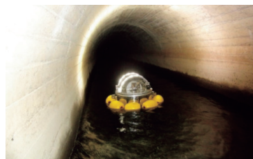
点検ロボットによる通水中の水路トンネルの点検
