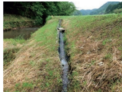
水田を産卵場とする魚類の移動経路を確保する水田魚道
