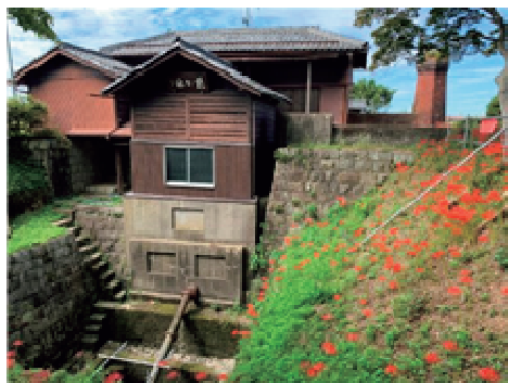
龍ヶ池揚水機場（滋賀県豊郷町）
