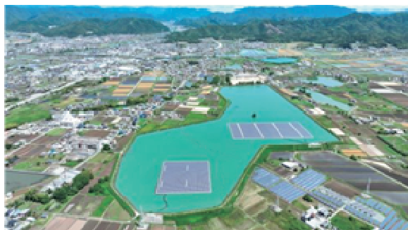
西光寺野疏水路（兵庫県姫路市等）
