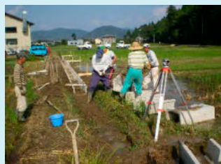
地域住民が参加する 直営施工による水路の更新 資料：グリーンネットさばえ
