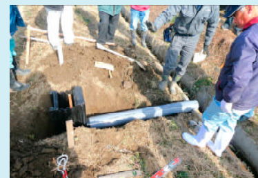
水位調整機能を持つ排水橋の設置
