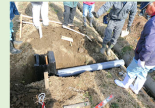
水位調整機能を持つ排水樹の設置
