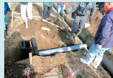
水位調整機能を持つ排水柵の設置
