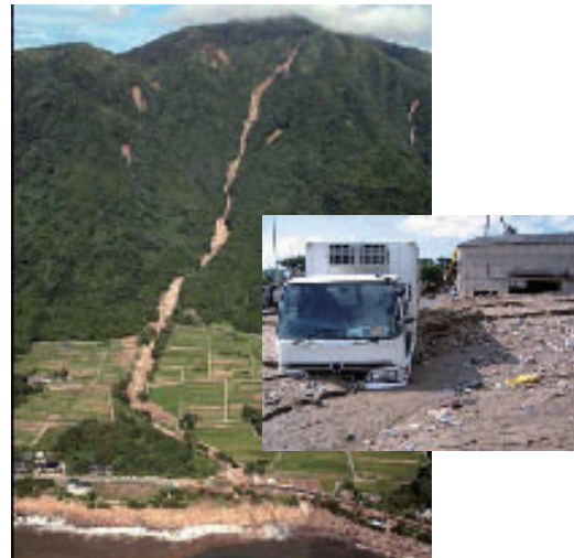
台風第4号による被害（鹿児島県南大隅町）
