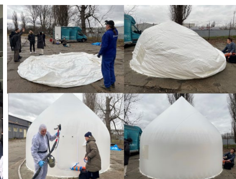
ポーランドでの簡易倉庫の 試験施工 (2024.12)
