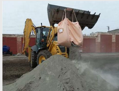
土壌改良材（STEIN）の試験施工 (2025年10月@ウクライナ)
