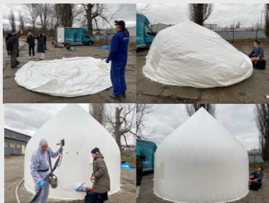
簡易倉庫の試験施工 (2024年12月@ポーランド)
