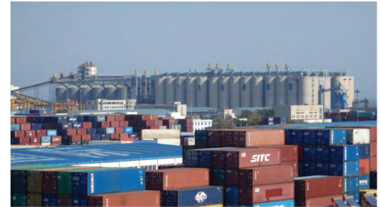
大連港の穀物サイロ (写真奥)
