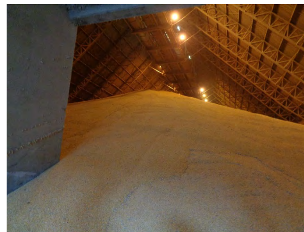
南東部サントス港のとうもろこし倉庫。 当該倉庫には9万トンの穀物を貯蔵可能。
