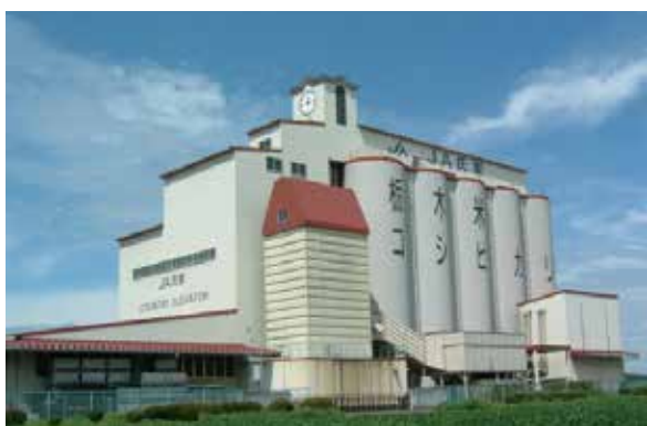
穀類乾燥調製貯蔵施設(栃木県)
