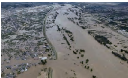
千曲川の堤防決壊による長野県長野市の湛水状況
