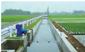
排水路の整備により湛水被害を解消
