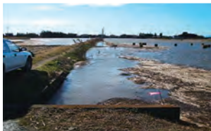
豪雨により溢水被害が発生
