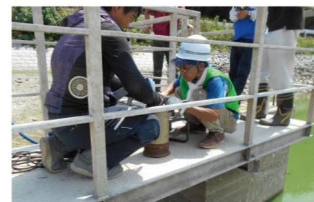
ポンプの設置
