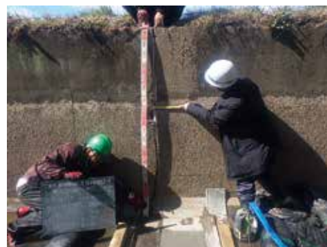
開水路補修立会
