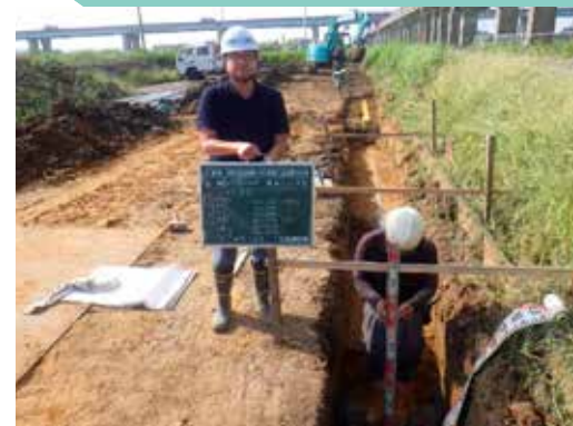
施工管理状況（現場監督）
