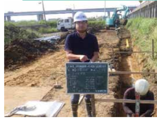
施工管理状況（現場監督）
