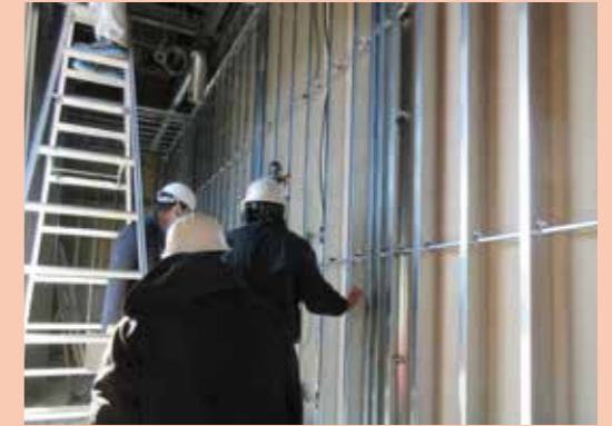
補助事業を活用した工場の竣工検査
