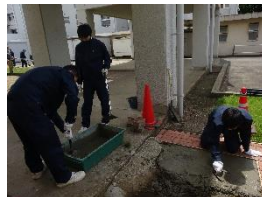
土木施工（3年生）
