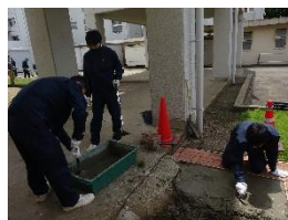
土木施工（3年生）
