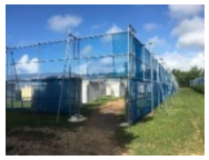
防風ネットの設置
