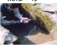
水路のひび割れ補修
