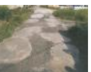
農道の窪みの補修
