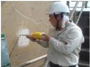
老朽化した施設の機能診断
