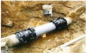
漏水防止のための整備
