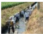
水路の泥上げ
